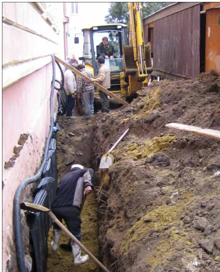
V roku 125.výročia vzniku Gemersko-malohontského múzea v Rimavskej Sobote sa realizuje nielen rekonštrukcia strechy, ale aj izolácia obvodových múrov a odvlhčenie muriva. Foto: M.Lichanec
