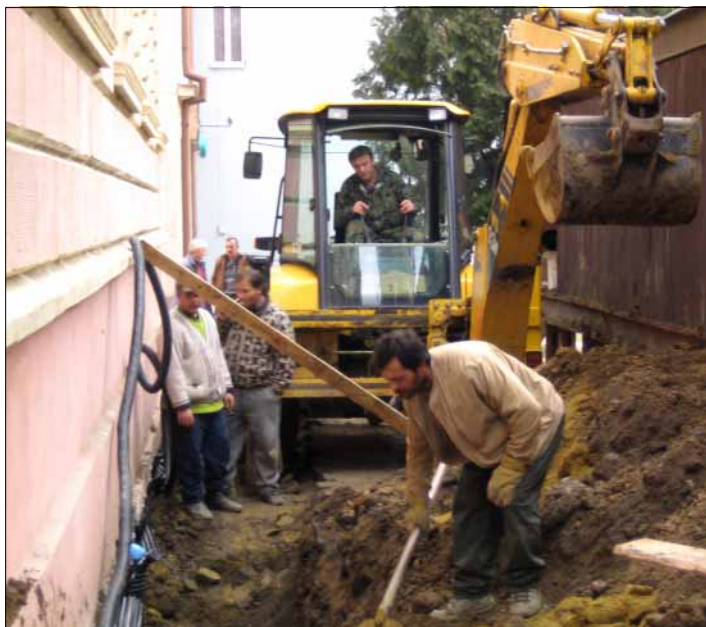
V roku 125.výročia vzniku Gemersko-malohontského múzea v Rimavskej Sobote sa realizuje nielen rekonštrukcia strechy, ale aj izolácia obvodových múrov a odvlhčenie muriva. Foto: M.Lichanec
